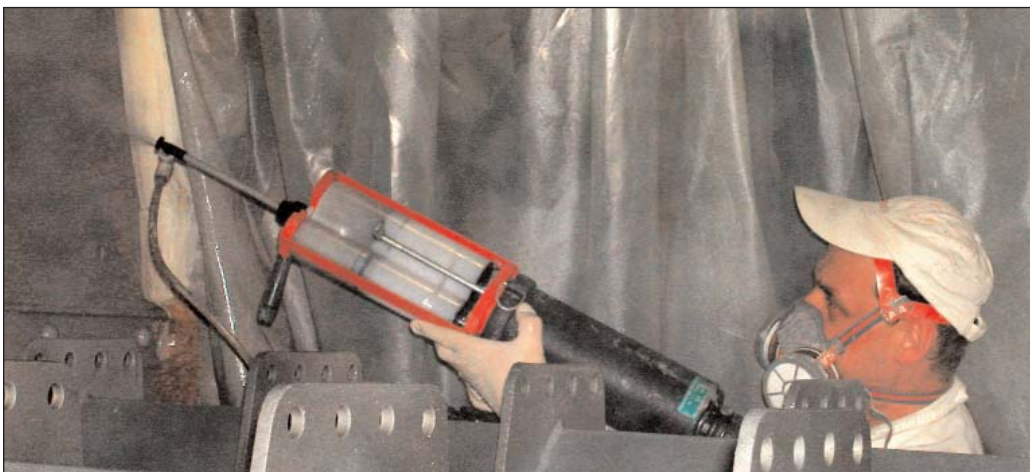
Erfolgreicher Abschluss einer Testserie bei JÖST: Mit der Kartuschen-Spritzpistole wird die Polyurethanbeschichtung aufgebracht.
